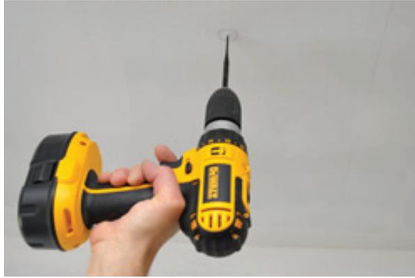
شكل (136): حفر مكان التثبيت في السقف بواسطة المقدح الكهربائي
