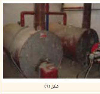
أما إذا كانت حزمة الأنابيب تشكل مجمعا للمياه المراد تسخينها وتحيط بها السنة اللهب والغازات الساخنة، سمي هذا النوع من مراحل أنابيب الماء (water tube). وفي هذا النوع تتراوح أقطار الأنابيب من (٢٥-١, ٢) إنش، وقد يزيد عددها في بعض المراحل عن مائة أنبوبة وهذا النوع غالبا ما يستخدم لتوليد البخار في المنشآت والمصانع.
