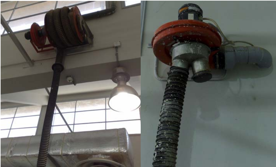
الشكل (٥- ١) يبين إحدى الطرق للتخلص من غازات العادم وهي ثابتة على جدران الورشة
